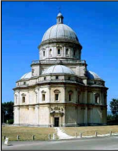
115- Chiesa della Consolazione di Todì
